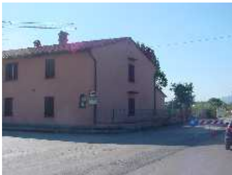
VEDUTA VIA SETTOLA ANGOLO VIA PIAVE 2
