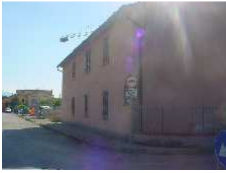
VEDUTA VIA SETTOLA ANGOLO VIA PIAVE 1
