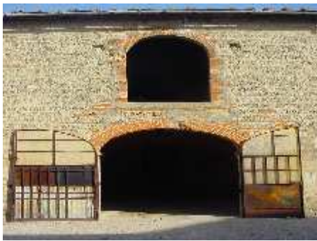
DETTAGLIO FACCIATA SUD
