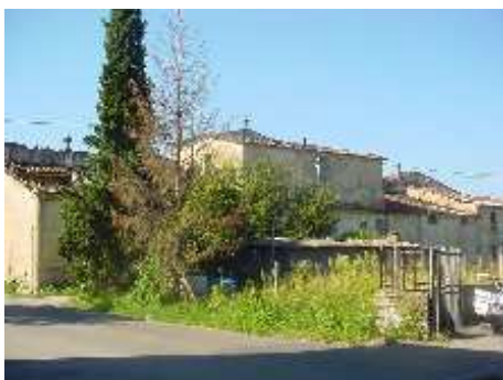
VISTA NORD-EST SCUDERIE
