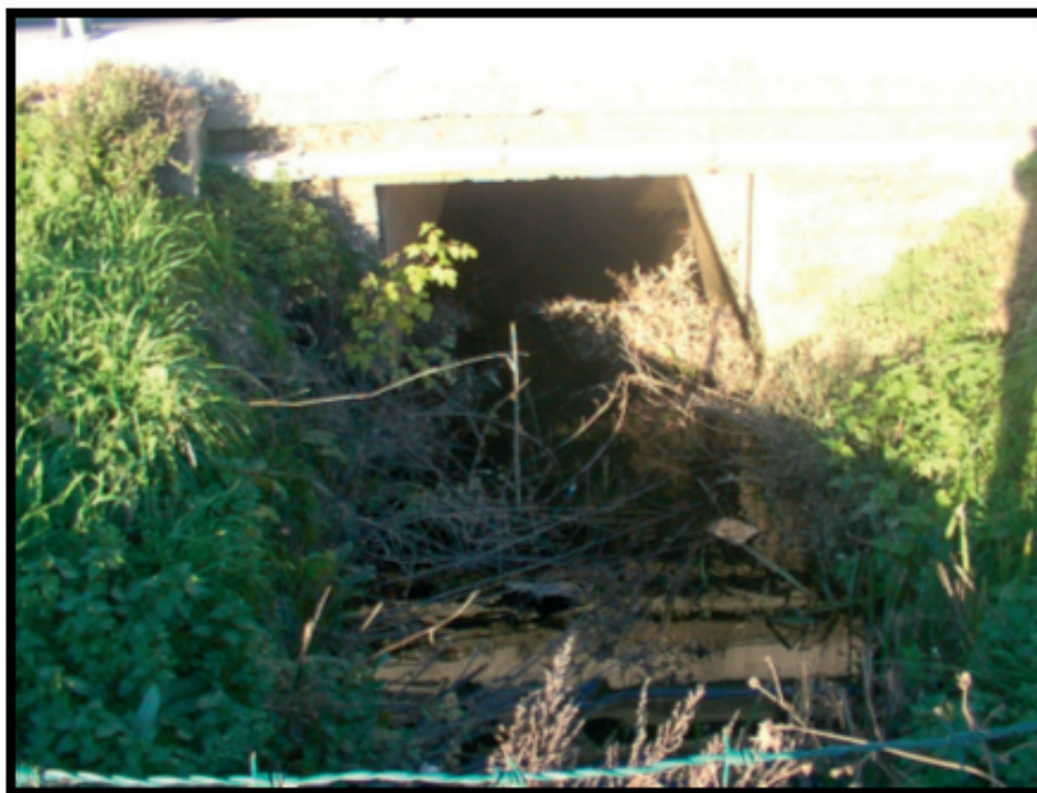
Canale con sottopasso autostrada, Agliana. Foto M. Petrolo
