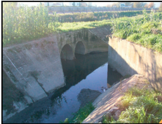
Esempio di corridoio ecologico. Collegamento sotto autostrada a sud del lago "1° Maggio". Agliana, Foto M. Petrolo
