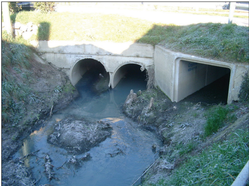
FOTO 3 - Sezione di chiusura dei bacini 3, 4, 5, 6, lato valle - uno scatolare a sezione quadrata 1,5 x 1,5 + 2 tubazioni in calcestruzzo di diametro 120 cm.
