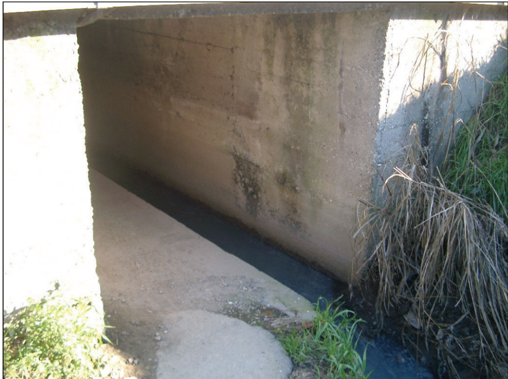
FOTO 2 - Sezione di chiusura bacino 2 - scatolare in calcestruzzo a sezione rettangolare 2 x 2,5 metri
