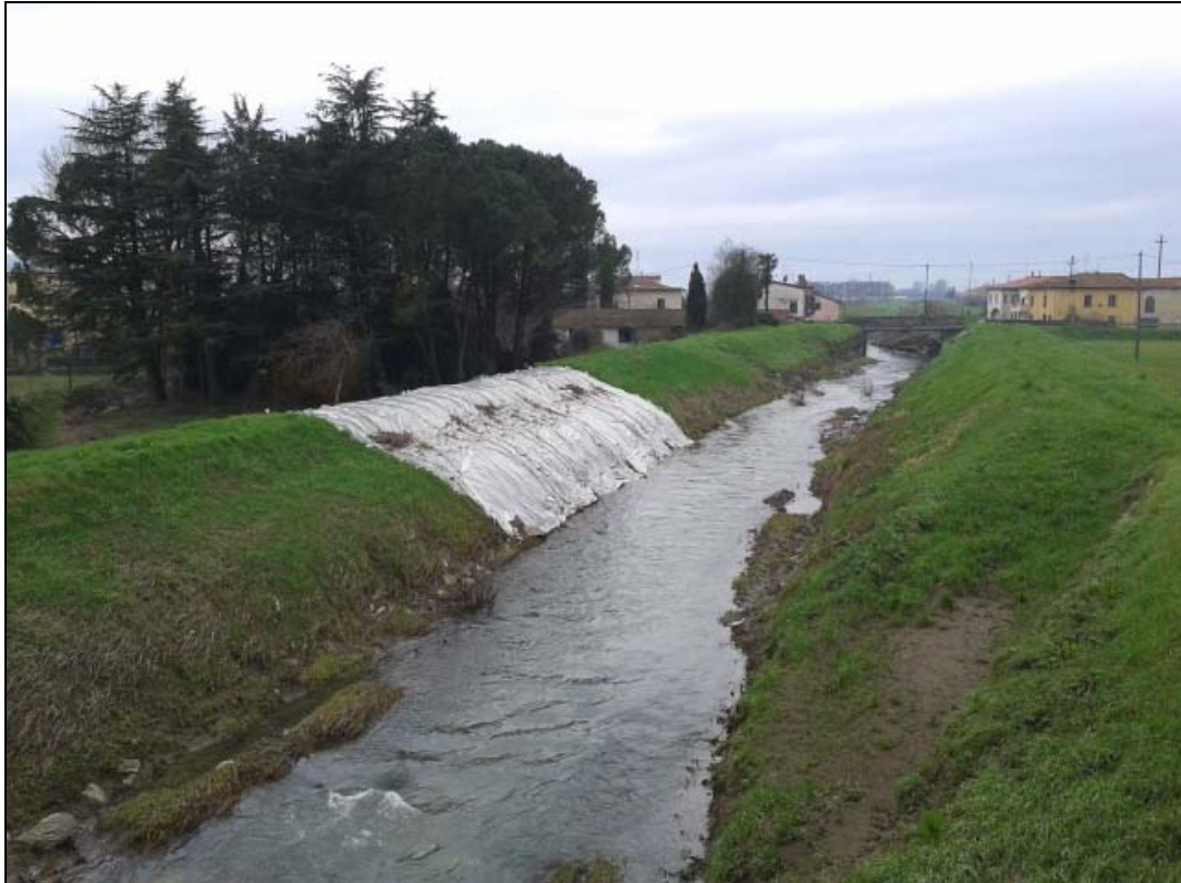
Figura 2-6 – Rilevati arginali nel tratto a monte del ponte di via Carlo Marx.
