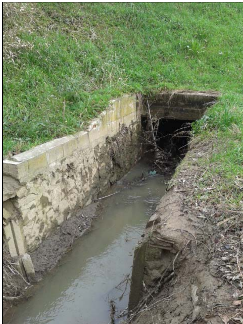
Figura 3-1 – Ingresso scarico canale di acque basse in prossimità del ponte di via Carlo Marx.
