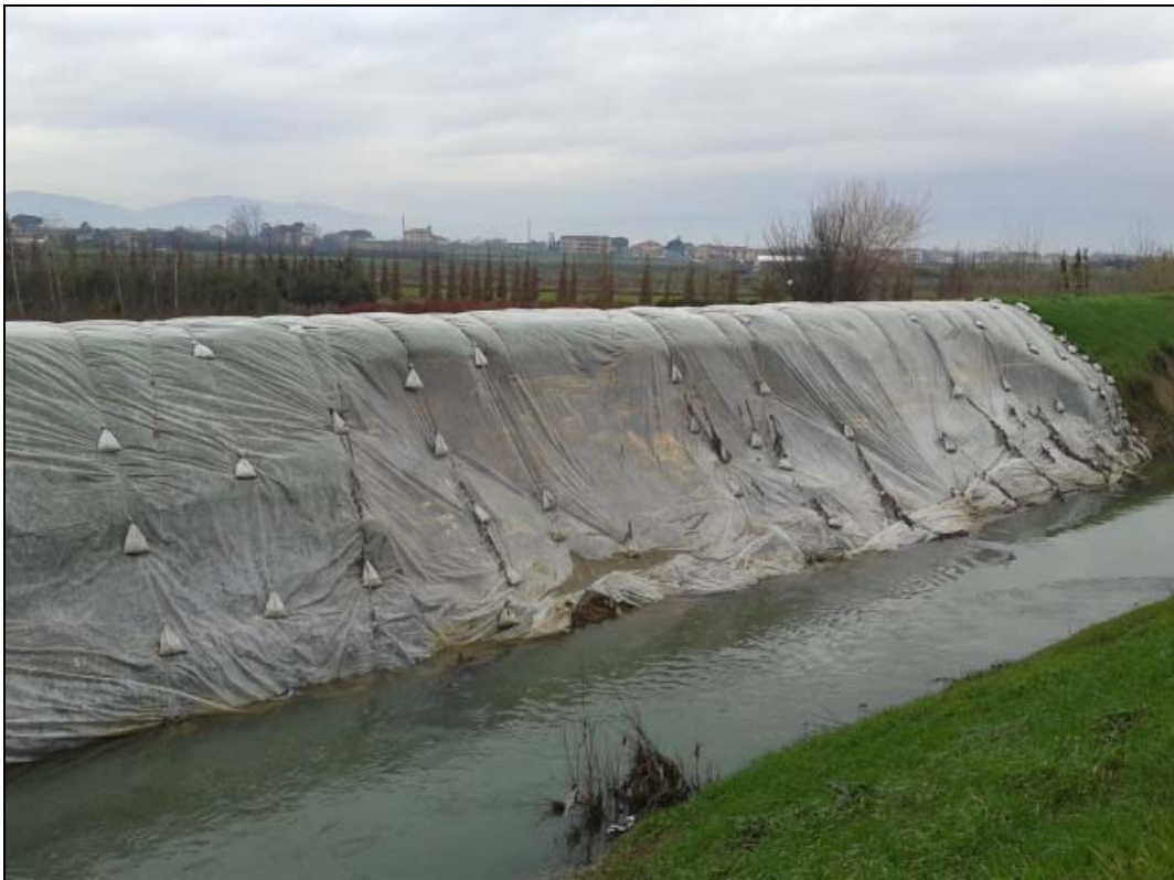
Figura 2-3 - Particolare sistemazione nel tratto di intervento a monte del ponte Berlicche.
