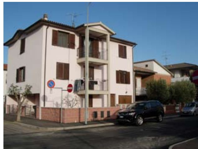
esempio di Tessuto insediativo ad assetto recente T2 - Palazzina fino al 3° livello fuori terra arretrata e non dal filo strada con presenza di giardini pertinenziali - Loc. Le Coltie Venturina
