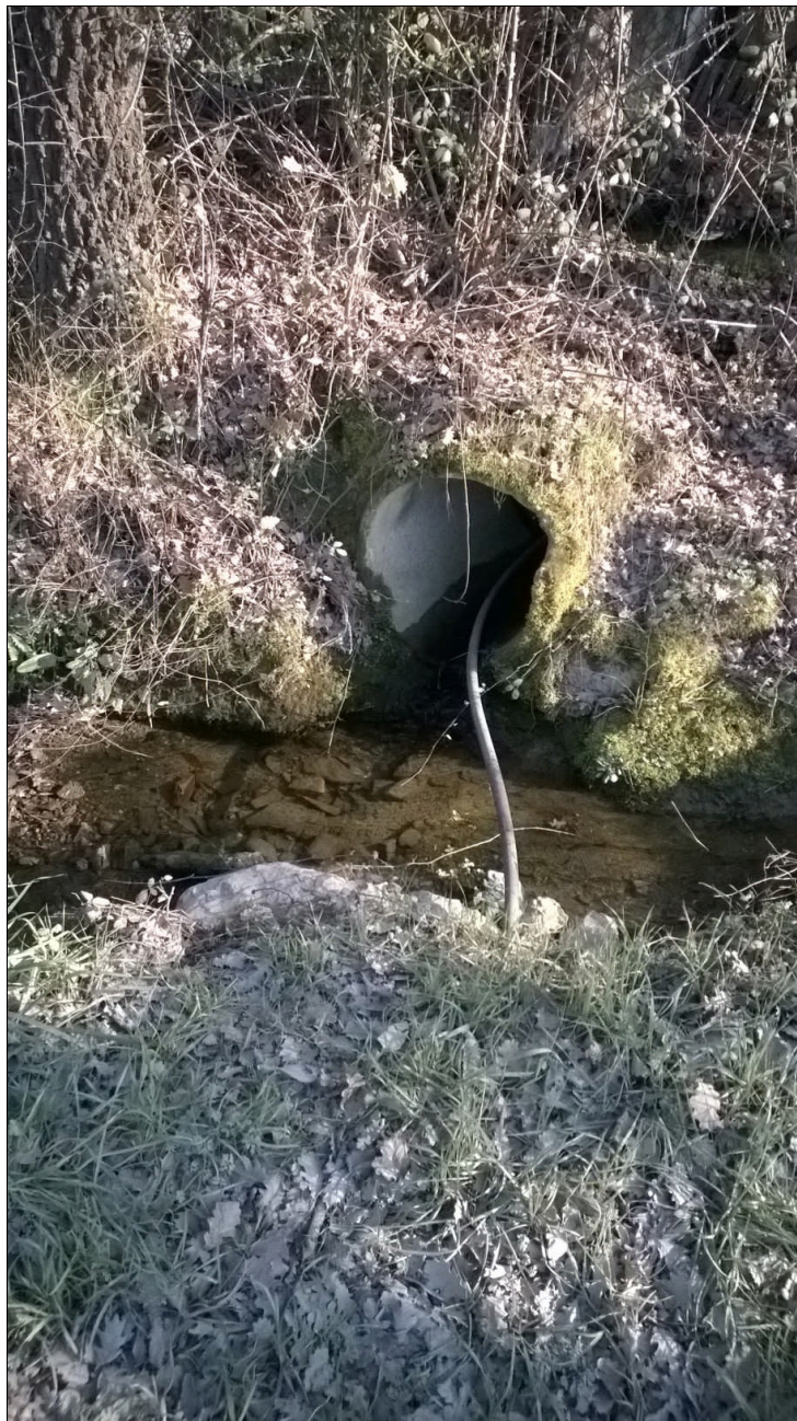
Fig. 4: Sbocco della tubazione nel fossetto di guardia della strada bianca (Sezione Af2_BMC_sf_1)
