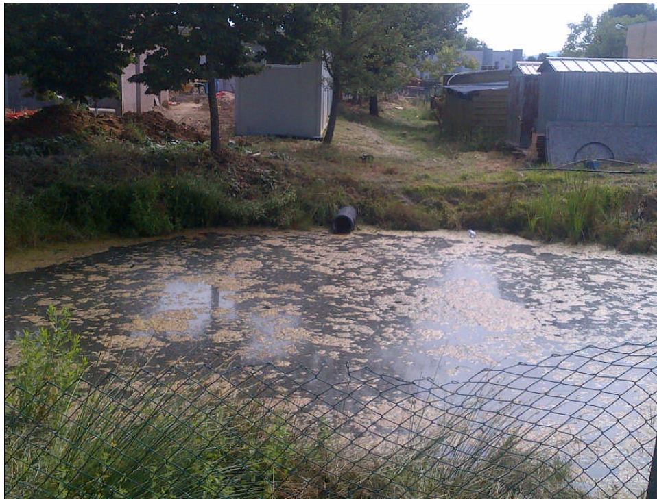
Fig. 15: Particolare del fosso F_ai all'altezza delle sezioni n. 0.9 e n. 0.8
