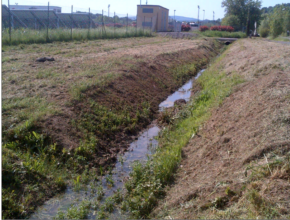
Fig. 12: Particolare del fosso Af1_BMC all'altezza delle sezioni n. 7 e 6
