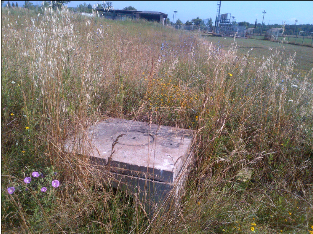
Fig. 23: Particolare del tombino presso cui inizia il tratto tombato dell'Af1_BMC_campoFV; sullo sfondo è chiaro l'andamento del terreno verso il campo sportivo, e si evince anche come la piccola costruzione di fianco al campo sia posta a quota più elevata
