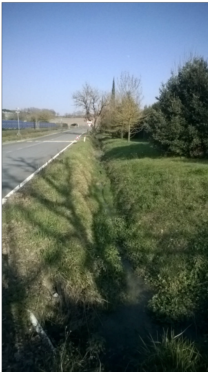
Fig. 13: Particolare del fosso Af1_BMC all'altezza delle sezioni n. 12 e 11
