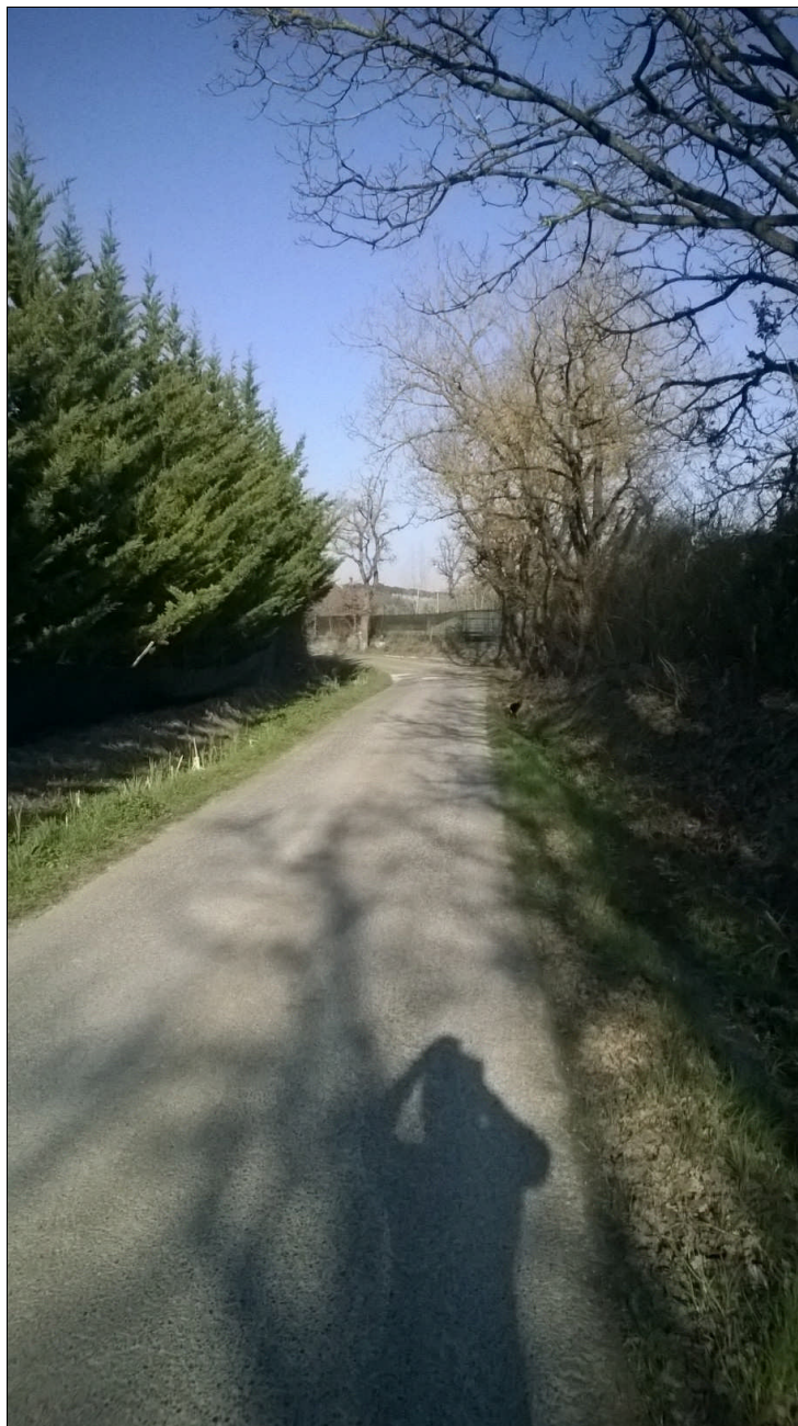
Fig. 7: Secondo tratto del fossetto destro in contropendenza, oltre la sezione Af2_BMC_sf_0.5 (in lontananza si nota l'uscita di un ulteriore scarico di uno stabilimento industriale)
