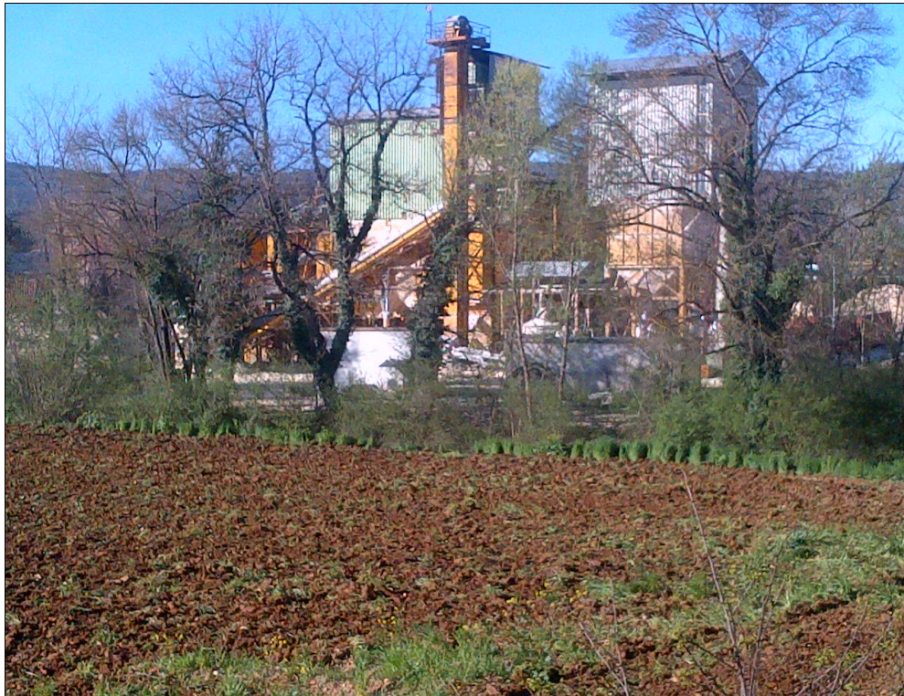
Fig. 40: Immagine della sponda sinistra del Fiume Elsa a monte dell'attraversamento della strada per Pievescola (sullo sfondo è mostrato l'impianto di lavorazione inerti in destra idraulica)
