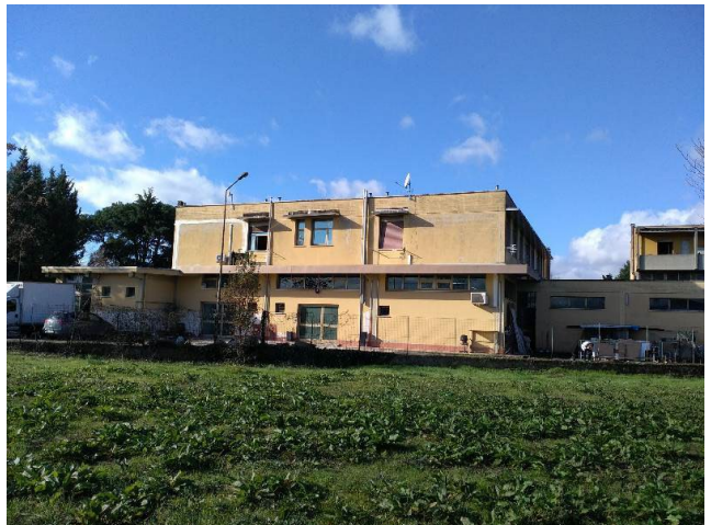
area produttiva e commerciale (U1.6) e altre aree produttive di fondovalle (U1.7)
