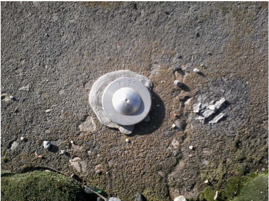
Figura 2-3-Caposaldo sul ponte della Variante Pratese.
