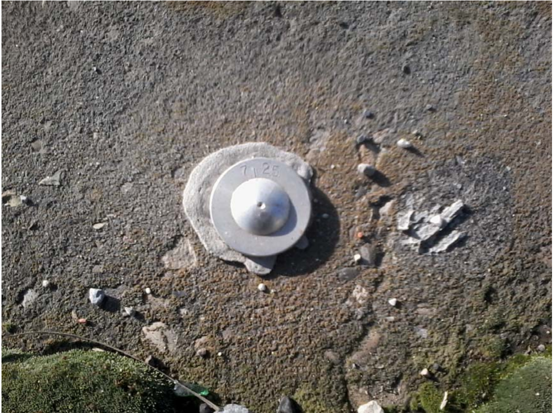
Figura 3-5-Caposaldo sul ponte della Variante Pratese.
